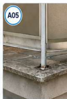
Usura sigillature e ossidazione elementi metallici.
