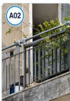
Segni di usura su ringhiera e sigillature su giunti.
